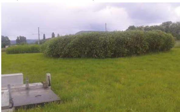
Filtre planté de roseaux, à côté du pilote du laboratoire DEEP.
