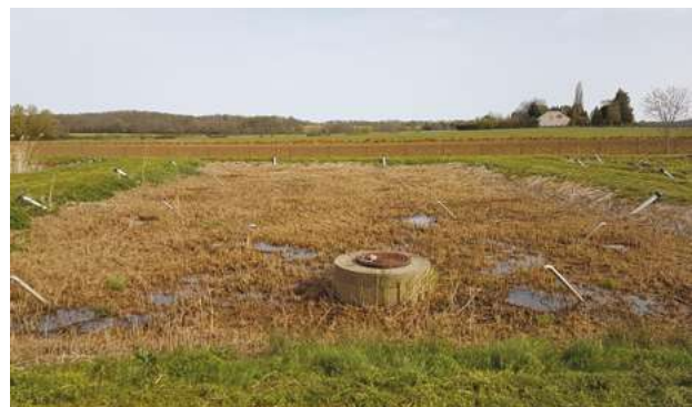
Filtre planté de roseaux après faucardage (fauçage des végétaux qui bordent les cours d'eau).
